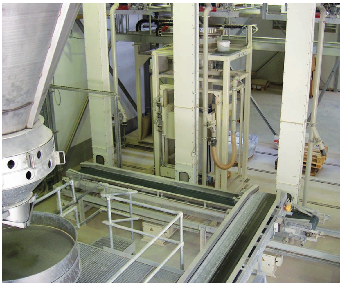
Rozdział mas ceramicznych do napełnienia silosów.
